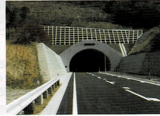
白方トンネル
