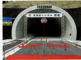
令和7年3月に完成した 五色台トンネル
