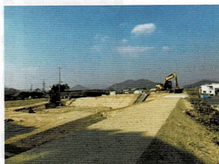
防災重点農業用ため池の改修工事
